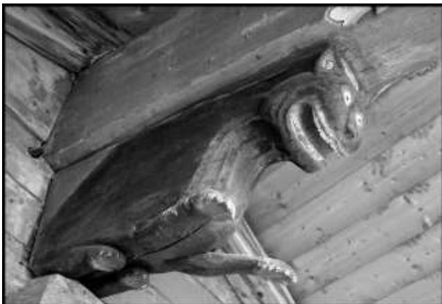
Figur an der Firstpfette, die die Jahreszahl 14.. trägt. Solche Figuren sollten Schaden vom Haus fernhalten.
