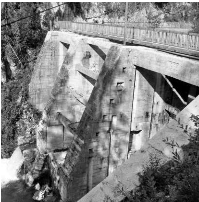
Die Erzherzog-Johann-Klausen mit dem neuen 1953 errichteten Betonsperrwerk (Quelle: Wikipedia)
